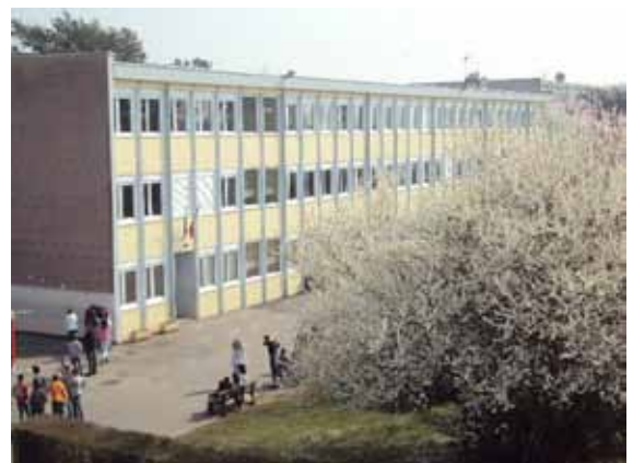
Collège du Parc des Chaumes
