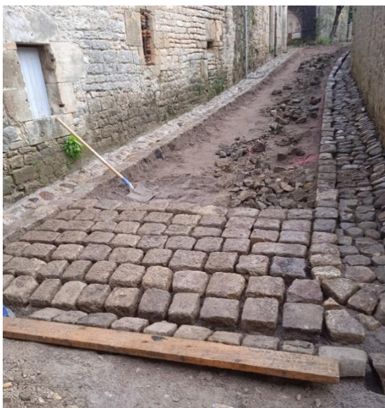
Rue de l'Hôpital (pendant les travaux)
